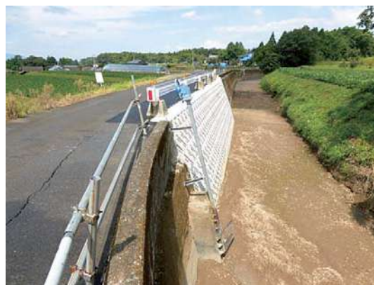
応急本工事完了
